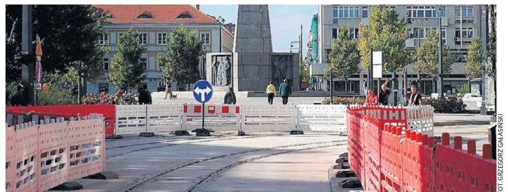
Kolejna naprawa łódzkiego pl. Wolności - po wielkiej przebudowie tej centralnej przestrzeni miasta rozpoczętej w 2022 roku - dobiega końca.
