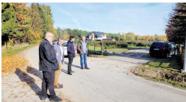
28 października powiat przekazał plac budowy na potrzeby przebudowy i rozbudowy drogi powiatowej w miejscowości Pasieki.
