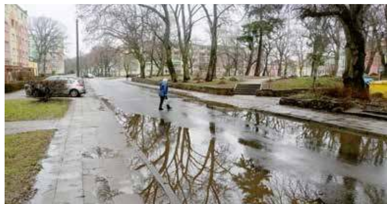
Dla osób wychodzących z parku i idących w stronę bloków, nie ma wygodnego przejścia dla pieszych
