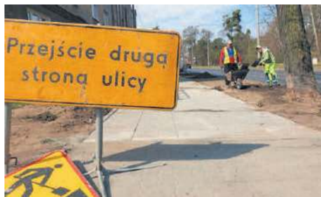
Nowe płytki i kostki wosną układane były, między innymi, wzdłuż ulicy Nakielskiej na Wilczaku
