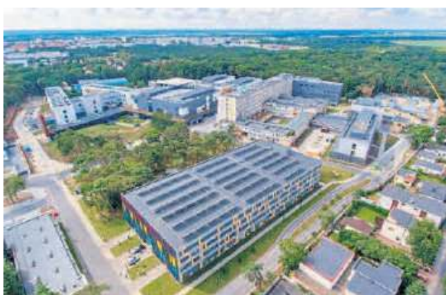
Rozbudowywany Wojewódzki Szpital Zespolony w Toruniu. Powołana w środę specjalna komisja ma w ekspresowym tempie zakończyć wszystkie prace budowlane
