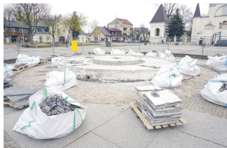
Węgrowska fontanna w budowie
