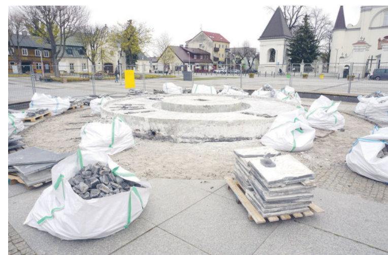
Węgrowska fontanna w budowie
