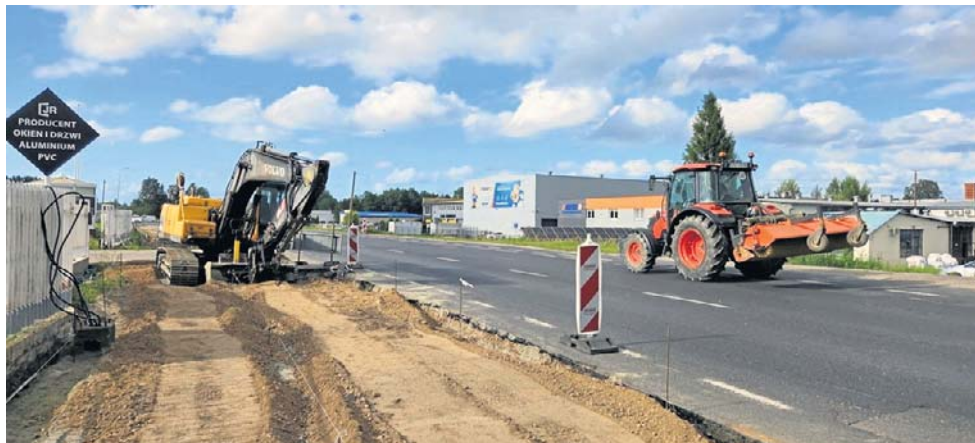
Budowa chodnika i ścieżki rowerowej na ulicy Portowej w Słupsku
