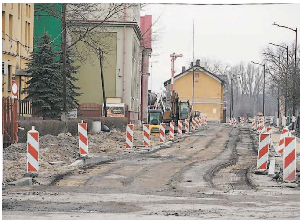
W pierwszym etapie przebudowie poddany został blisko półkilometrowy odcinek drogi
