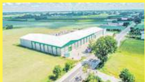
Nowoczesna hala przemysłowa o łącznej powierzchni 3 150 m 2 usytuowana na działce hektarowej w miejscowości Wołyn, 885 851 172
