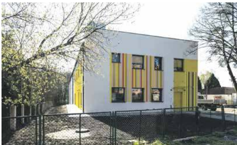
Budynek nowego przedszkola robi wrażenie i przyciąga uwagę przyjemną kolorystyką
