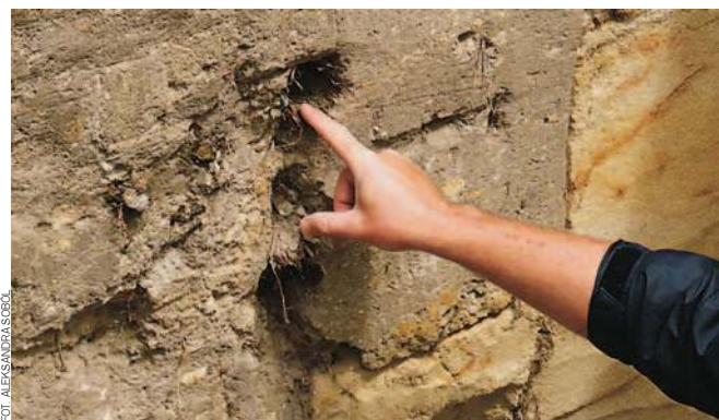
Wlot po drewnianej belce będącej częścią konstrukcji ziemianki
