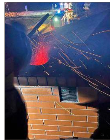
Tak wygląda pożar sadzy w kominie. Fot. OSP Pilžno.
