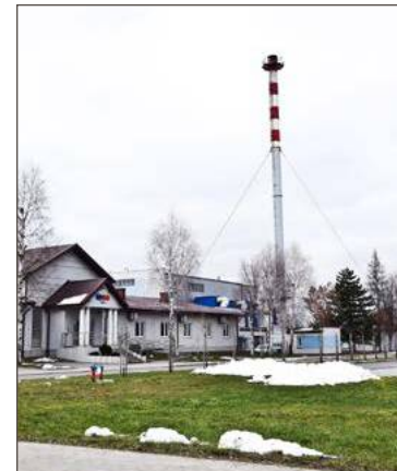
Spalarnia ma powstać na terenie MPEC w Dębicy.
