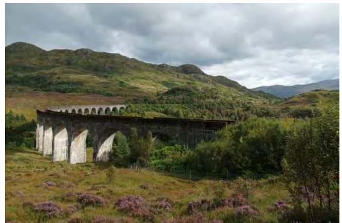
Wiadukt kolejowy w Glenfinnan
