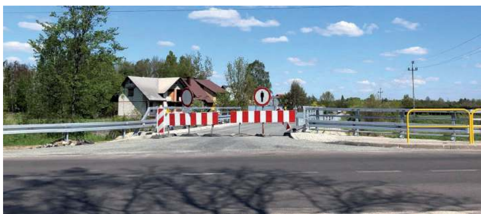
Związek Dróg Powiatowych wyjaśnia, że główne utrudnienia wynikają z jednostronnego zamknięcia ulicy Granicznej z powodu generalnego remontu mostu
