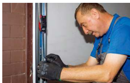
❼ Osadzenie i wyregulowanie sprężyn, naciągnięcie stalowych linek.
