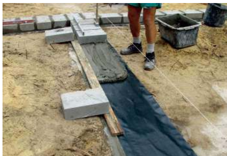
Hydroizolacja pozioma na ławach fundamentowych.
