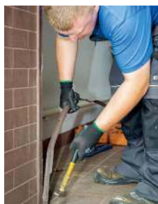
❷ Demontaż. Zdjęcie skrzydła i odcięcie wszystkich elementów ościeżnicy.
