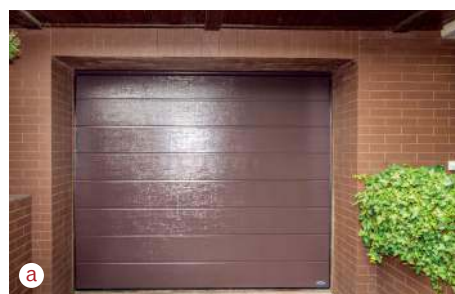
❶ Brama po zakończeniu prac – z zewnątrz (a) i od środka (b). Skrzydło musi szczelnie przylegać do ościeżnicy, nie opadać, a do jego podnoszenia powinno wystarczyć użycie niewielkiej siły.
