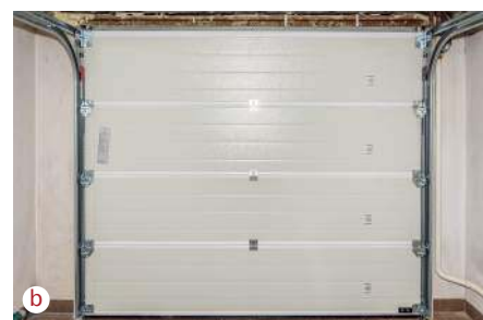
❶ Brama po zakończeniu prac – z zewnątrz (a) i od środka (b). Skrzydło musi szczelnie przylegać do ościeżnicy, nie opadać, a do jego podnoszenia powinno wystarczyć użycie niewielkiej siły.
