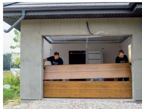
🔧 Bramę segmentową składa się z elementów mocowanych od dołu. WIŚNIOWSKI
