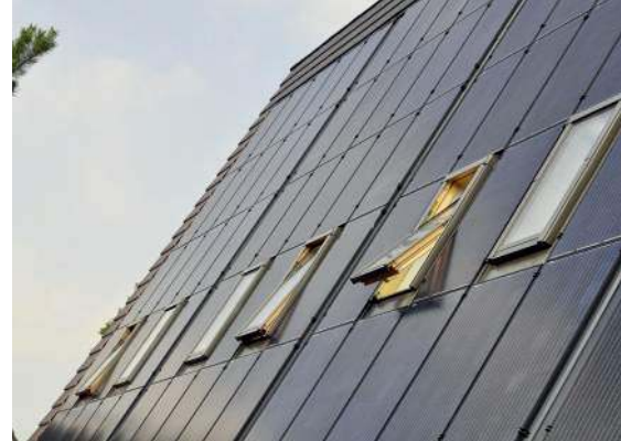
Panel PV można zintegrować z pokryciem dachu. CREATON POLSKA
