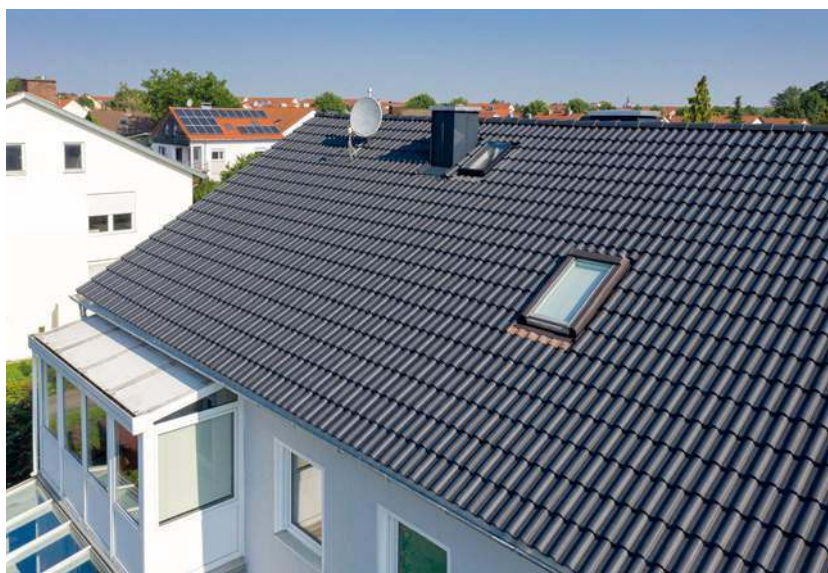
📍 Dachówki cementowe są trwałe, odporne na mróz i porastanie mchem. CREATON POLSKA
