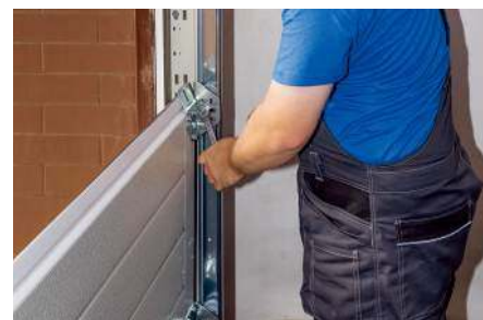
❻ Umieszczanie paneli w prowadnicy od dołu i łączenie ich zawiasami.
