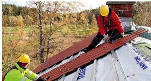
Wybór pokrycia to nie jedyne zadanie, przed którym stoi inwestor. Ważne też, aby do jego montażu zatrudnić sprawdzoną ekipę dekarską. RUUKKI
