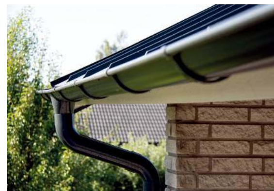
🔑 Przy kupowaniu stalowego systemu rynnowego, warto zapytać o grubość stalowego rdzenia i powłok ochronnych – im są one grubsze, tym lepiej. LINDAB
