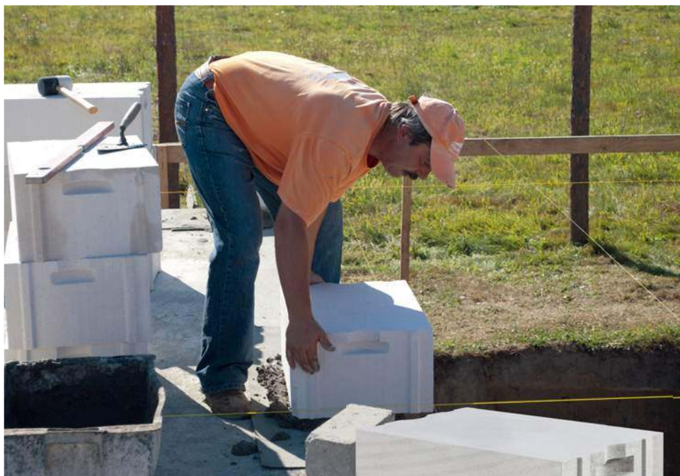
🔗 Bloczki z betonu komórkowego są duże i lekkie, a murowanie ułatwiają wyfrezowane uchwyty montażowe. TERMALICA (BRUK-BET), YTONG (XELLA)
