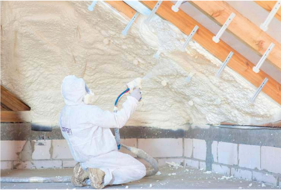
🔧 Piankę PUR aplikuje się metodą natryskową. Jest ona rozprężna, dlatego bardzo szczelnie wypełnia ocieplaną przestrzeń. PCC PRODEX
