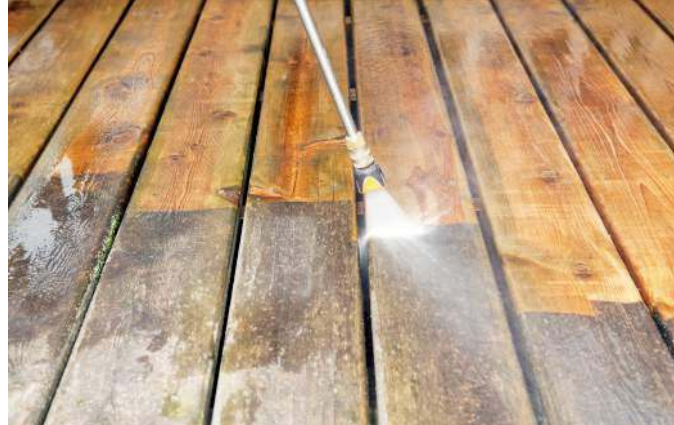
Deski drewniane lub z kompozytu mogą być gładkie lub ryflowane. Myje się je wodą z węża lub myjki ciśnieniowej. JAF POLSKA
