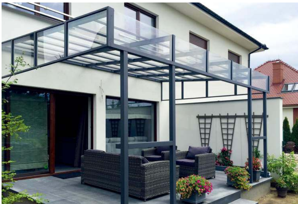
📍 Konstrukcja tarasu wykonana z aluminium, zadaszenie z poliwęglanu litego, który wyglądem bardzo przypomina szkło. Całość z nietypowymi ściankami bocznymi, które zabezpieczają taras przed deszczem i śniegiem. ALUNA
