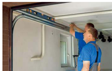
❹ Przykręcenie do sufitu górnych prowadnic tak, aby zachowywały poziom.
