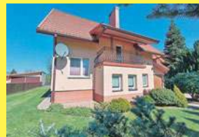
Dom przy ulicy Wyzwolenia, pow. 157,60 m 2 , 604 494 489
