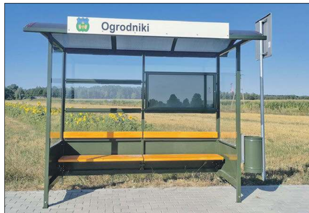
Zadanie, oprócz wykonania warstwy ścieralnej, obejmowało swoim zakresem również ustawienie zadaszeń przystankowych
