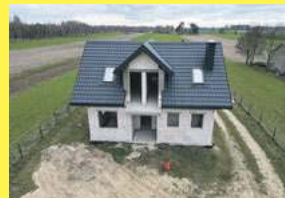
Dom w stanie surowym otwartym, Wólka Siemieńska, 885 851 160
