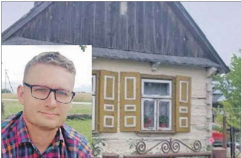
Dom, który chcą wyremontować mieszkańcy Zabiela, jest w złym stanie, dlatego Daniel Grochowski zaapelował o wsparcie
