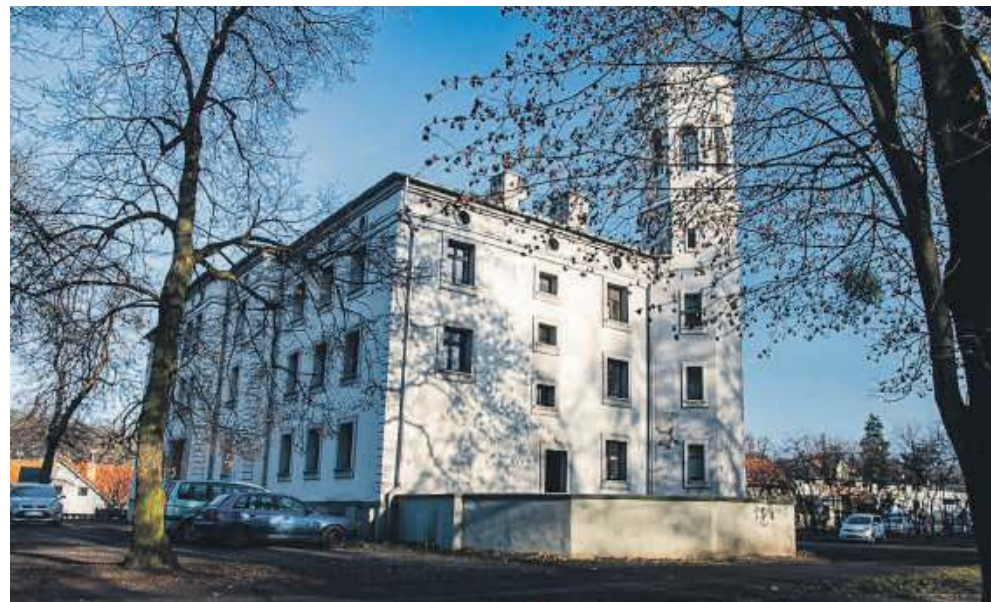
Obecnie trwają jeszcze prace przy remoncie dachu
