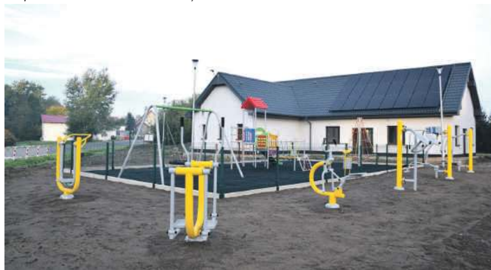
W Pierwoszowie przy nowej świetlicy powstaje infrastruktura rekreacyjno-sportowa
