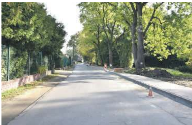
W Ozorowicach rozpoczęła się przebudowa drogi powiatowej nr 1366 D (ul. Pęgowska)
