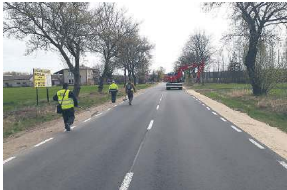
Na drodze powiatowej trwają ostatnie prace porządkowe
