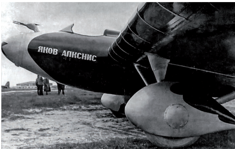
▲ Widok przodu szybowca G-31 „Jakow Ałksnis” z nazwą patrona na boku. W tej części kadłuba widoczna jest kabina pierwszego pilota. Widać komory transportowe w lewym skrzydle. Na pierwszym planie znajduje się owiewka kryjąca koło o dużej średnicy. Uwagę zwracają wsporniki podwozia odmienne niż we wcześniejszych wersjach szybowca.
