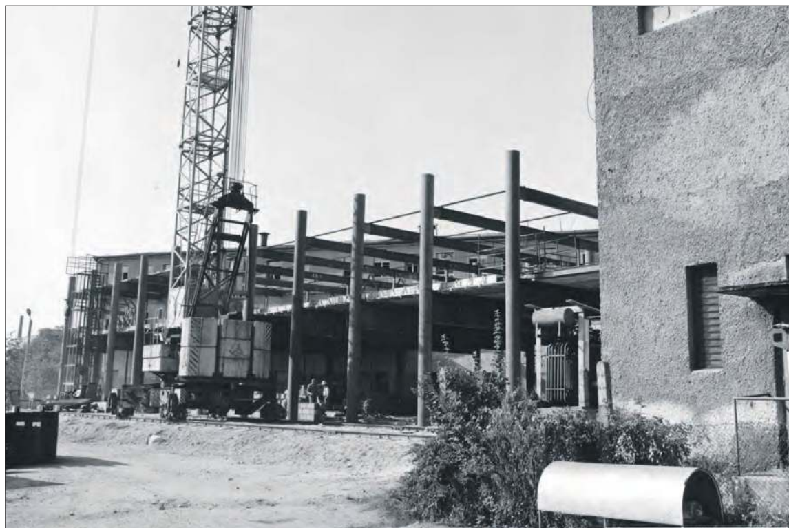
Rozbudowa zakładu w połowie lat 80. XX w. Szkielet konstrukcji wychodził poza obrys ścian budynku, tworząc charakterystyczną, istniejącą do dziś elewację.
