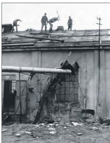
Rozbiórka starego budynku
