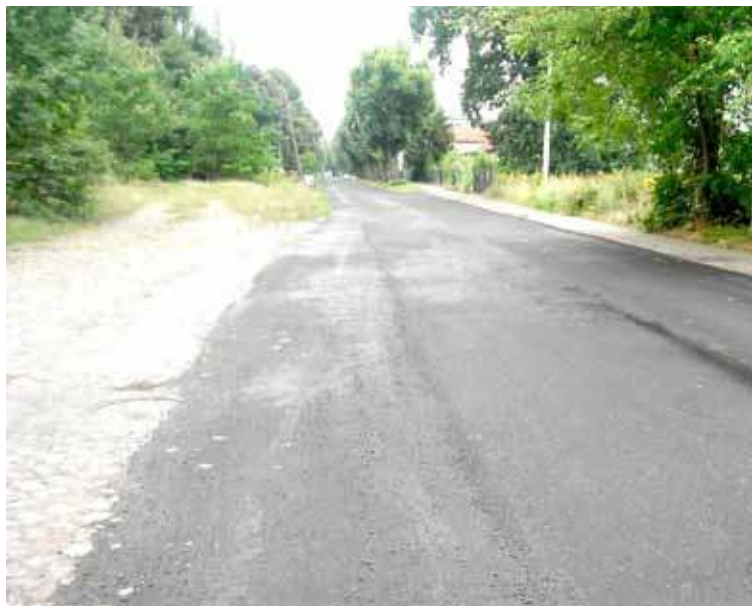
Oprócz zaplanowanych, dużych i kosztownych inwestycji miasto wykonuje też mniejsze prace w ramach bieżącego utrzymania ulic
