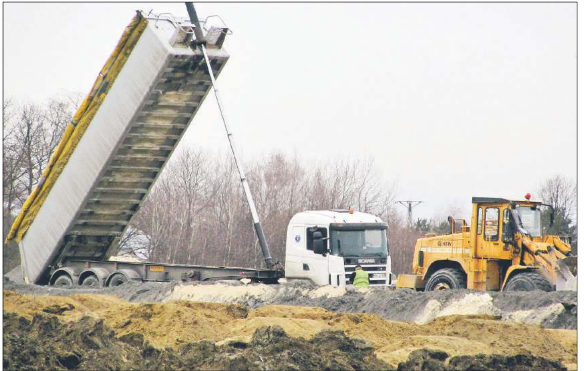
Widoczne na zdjęciu popielate kruszywo to ellmix. Do Brzeżnicy przywożony jest z elektrowni Połaniec.
