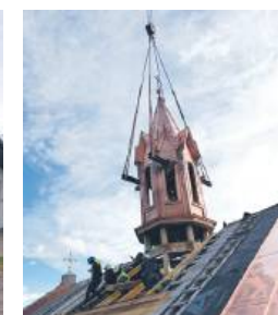
Remont wieżyczki kościoła
