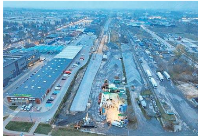
Trwa budowa stacji kolejowej w Łomży
