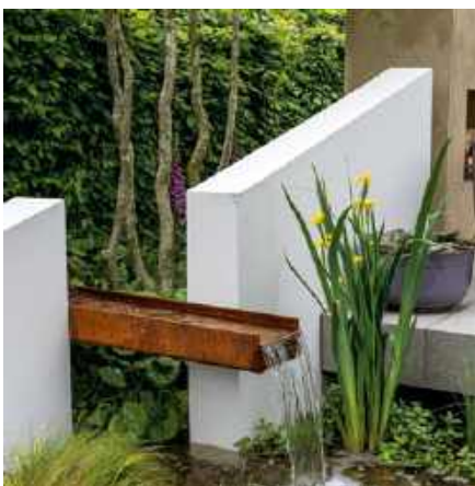
Wylewka ze stali corten odprowadza wodę do stawu obsadzonego roślinami wodnymi i bagiennymi
