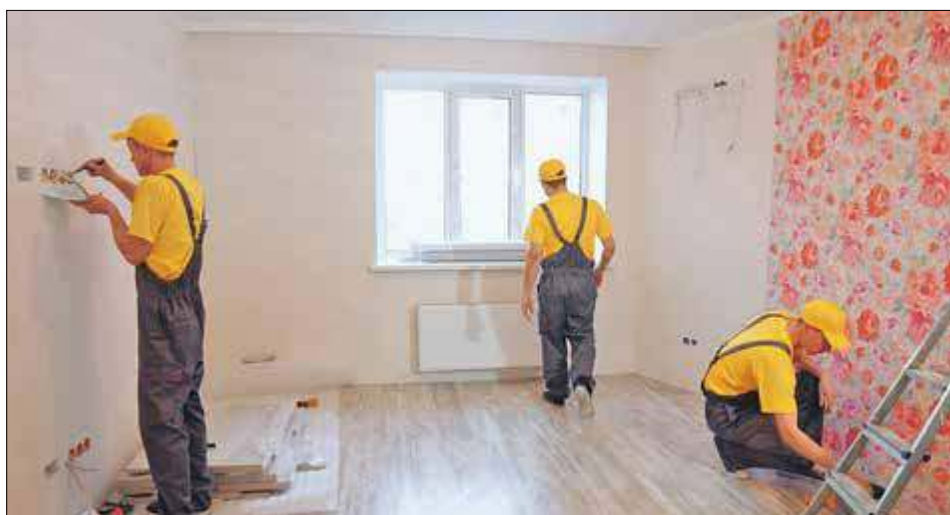
Nie wszystkie prace da się przewidzieć, szczególnie jeśli remontujemy stary budynek. Całkowity koszt zależy od rodzaju i jakości użytych materiałów
