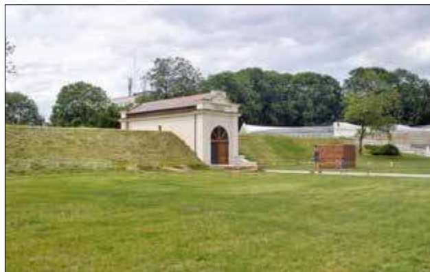
Wybudowano bramę i most koszarowy od strony zachodniej, odtworzono również fortyfikację
