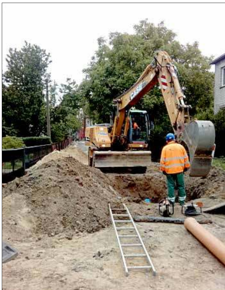
Intensywne prace dot. wymiany sieci wod-kan prowadzone były jeszcze na początku września br. Fot. UM Nowogard
