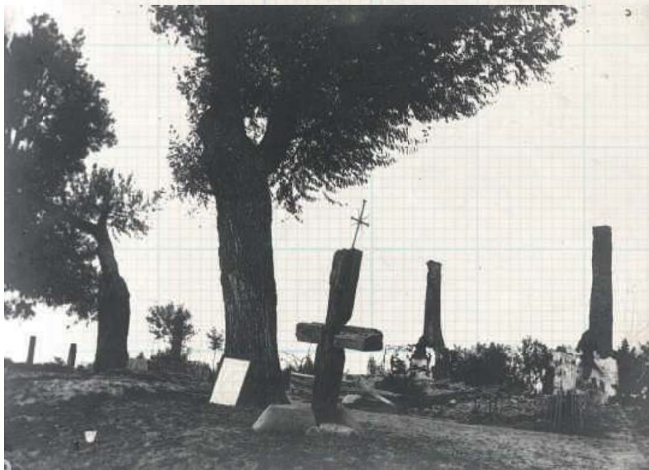
Zgliszcząca wsi Ruda - dzisiaj w gminie Serokomla w powiecie łukowskim. Rosjanie wycofując się stosowali taktykę spalonej ziemi. Niszczono zabudowania i zapasy tak, żeby nic nie wpadło w ręce wchodzących wojsk przeciwnika
