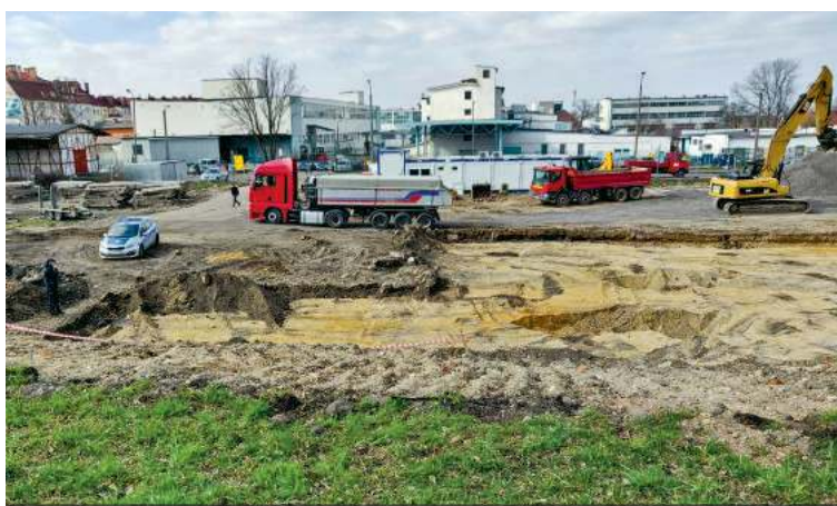
Najbliższe ulice od placu budowy zostały wyłączone z ruchu samochodowego i pieszego
