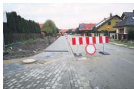
Remont ulicy Osadniczej
