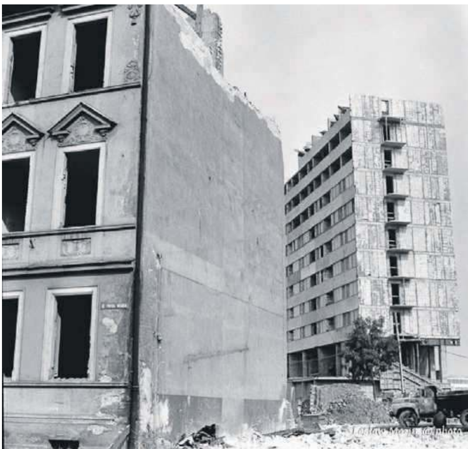
1970 - po lewej część budynku przy Piotra Własta 10 w trakcie rozbiórki, w głębi budowa budynku ul. B. Chrobrego 20, tzw. „wieżowca” przy dworcu PKS
