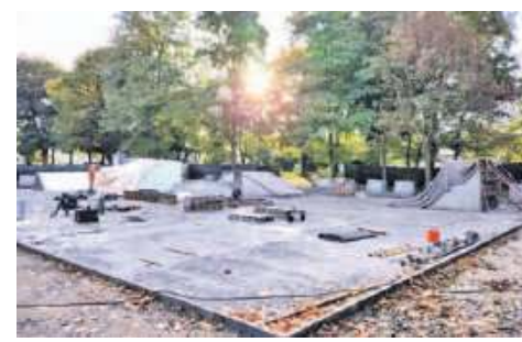
Trwa budowa oławskiego skateparku
