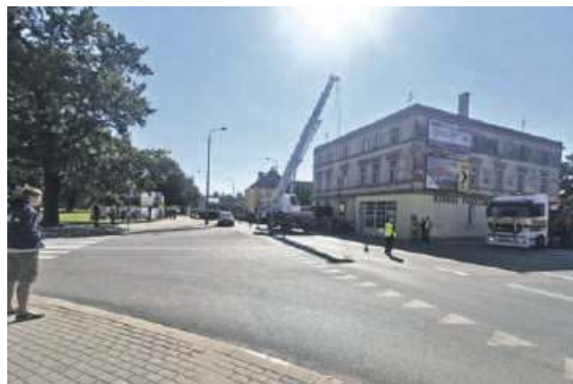
Rondo ma powstać w tym miejscu
