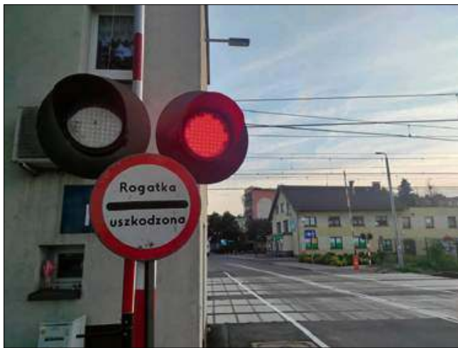
Przy torowisku (na czas awarii) zamontowano znak zakazu B-32b czyli „Stój - rogatka uszkodzona”. Część kierowców go ignorowała.
