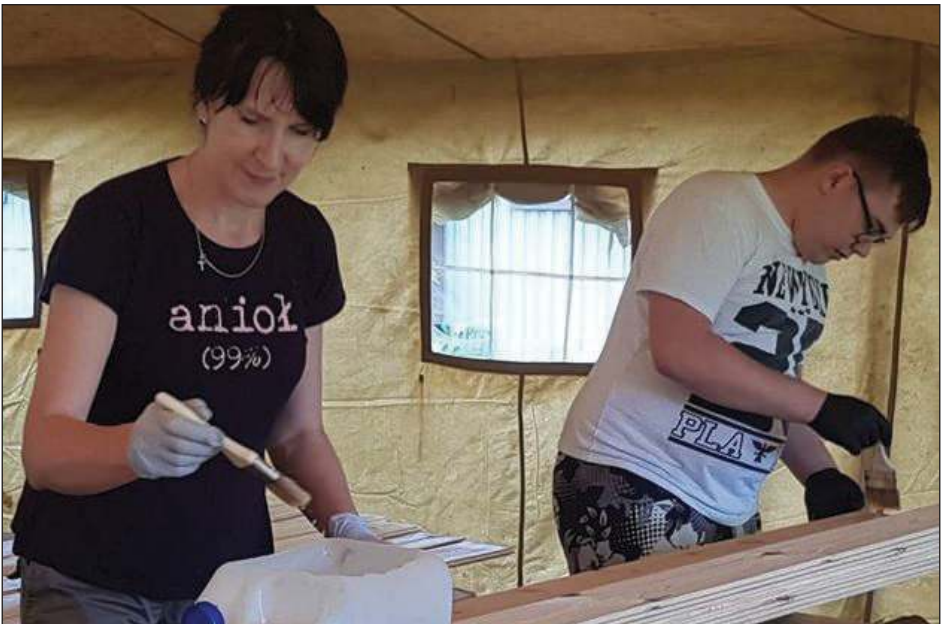
W prace przy budowie stancji włączyli się wszyscy druhowie. Razem czyścili i malowali drewniane elementy
