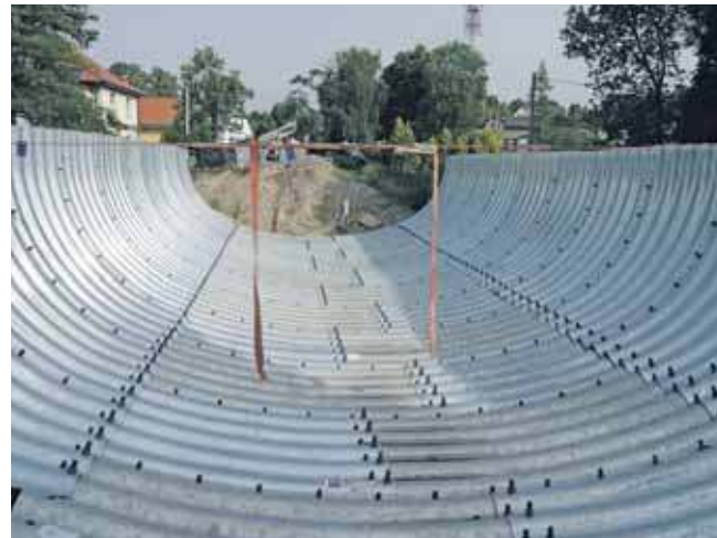
Na miejscu są tzw. łupiny, które będą potem montowane
