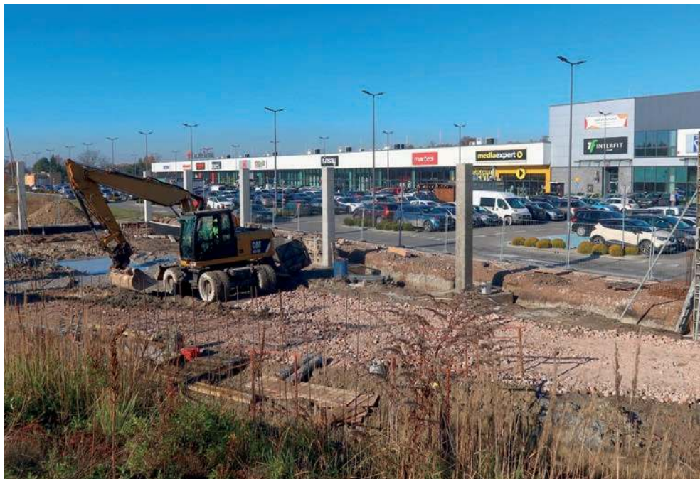
Trwa budowa nowego obiektu przy Kasztelanii
