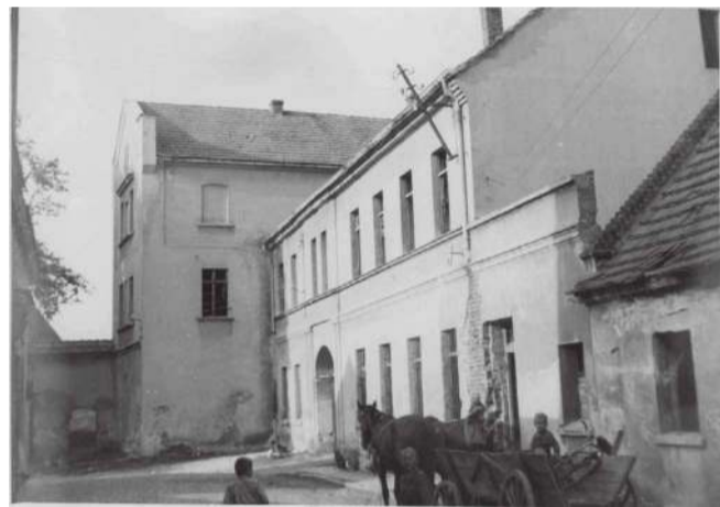
Budynek dawnego pałacu w stanie zachowania z 1957 r.
