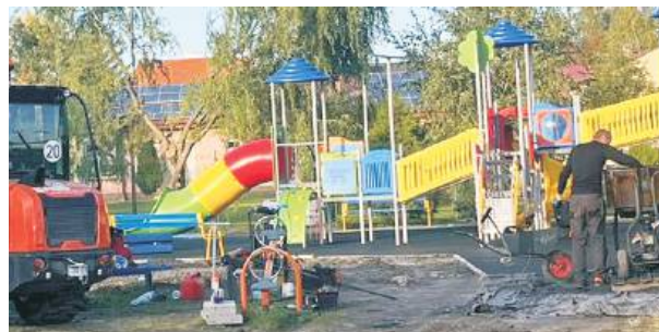
Na placu zabaw w Wiązowie zdemontowano stare urządzenia i rozpoczęto montaż nowych
