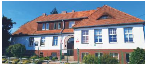
Szkoła Podstawowa w Żelowicach zostanie docieplona
