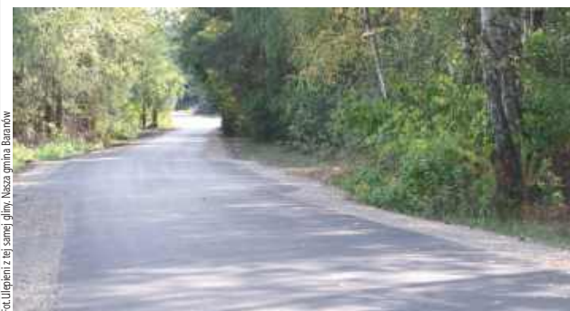
Zmodernizowana droga ma 452 metry długości
