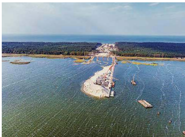
Budowa kanału na Mierzei Wiślanej powinna zakończyć się w 2022 roku
