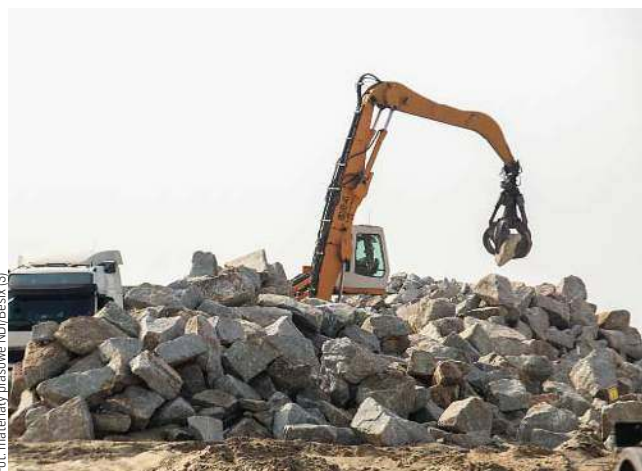
Rozpoczęto wykonywanie narzutów kamiennych na odcinku nasady falochronu zachodniego i wschodniego
