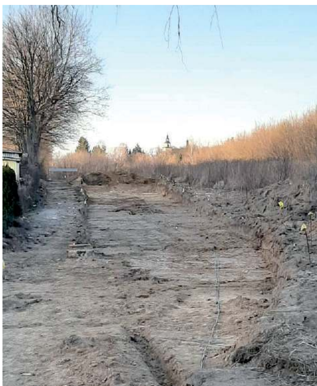
W ubiegłym tygodniu wykonawca rozpoczął prace. Zdemontowano dotychczasową nawierzchnię. Po remoncie będzie tu równiutki asfalt
