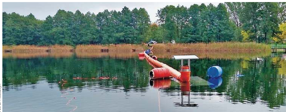
Zatapianie jednego rurociągu
