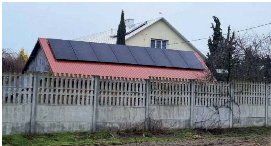
Pierwsze instalacje fotowoltaiczne już widać w Potoku Górnym. W sumie pojawi się ich 674
