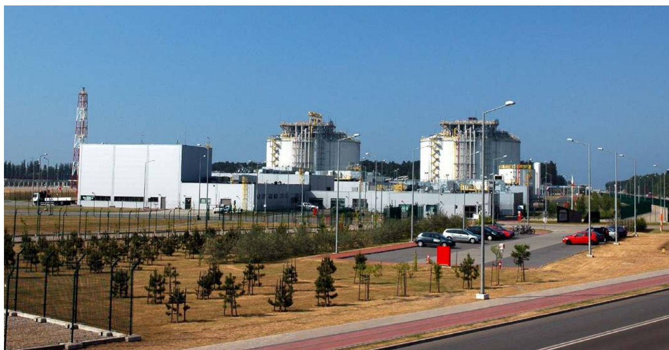
Fot. 3. Infrastruktura gazoportu w Świnoujściu
