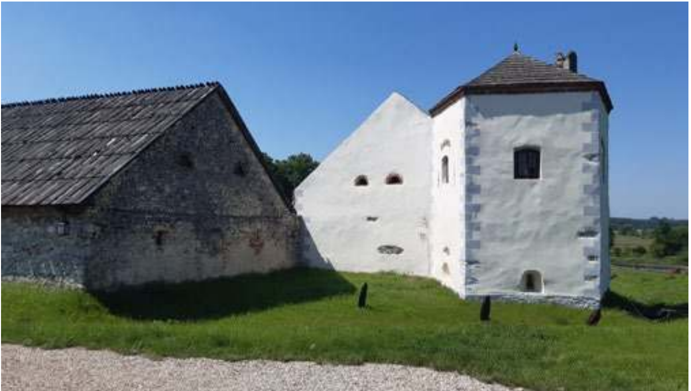
Sobków, XVI-wieczna fortalicja z niewielkimi basztami na narożach tego obronnego założenia
