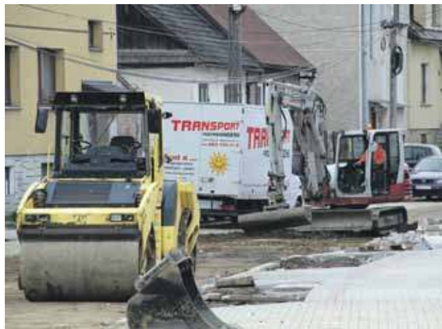
Jeszcze nieco ponad miesiąc i walce, koparki i inny sprzęt znikną z ul. Kasprowicza.
