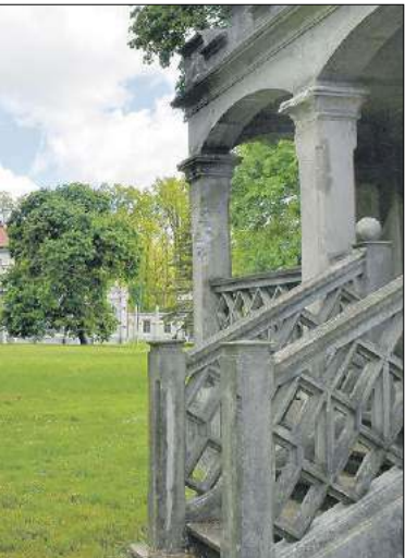
jest eklektyczny pałac, wybudowany Zamojskiego, ojca słynnego rzeźbiarza
