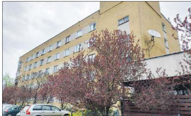
Na 9 maja wyznaczono termin podpisania aktu notarialnego, po którym właścicielem budynku przy ul. Okopowej 3 zostanie powiat bialski
