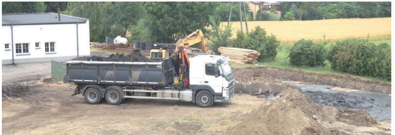
Pracownicy na placu budowy pojawili się 17 lipca. Ostatnio na placu budowy były obecne koparki, które odpowiadały za wykopanie ziemi pod fundamenty
