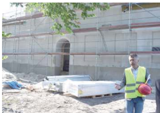
Prace w Osuchach są na dość zaawansowanym poziomie
