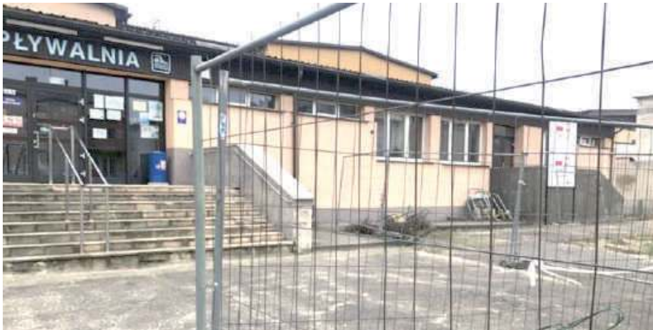
Basen w trakcie trwania remontu
