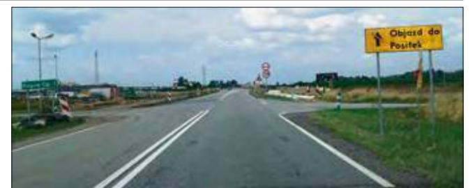
Wykonawca rozpoczął prace związane z robotami ziemnymi oraz konstrukcyjnymi w zakresie drogi głównej.
