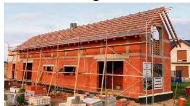
Rozstawione rusztowanie zostało skradzione z tego budynku.
