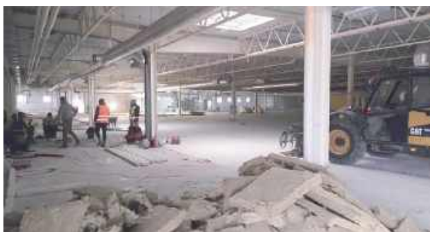
Panowie przygotowujący halę pod nową inwestycję dostali info, że będzie tu galeria handlowa
