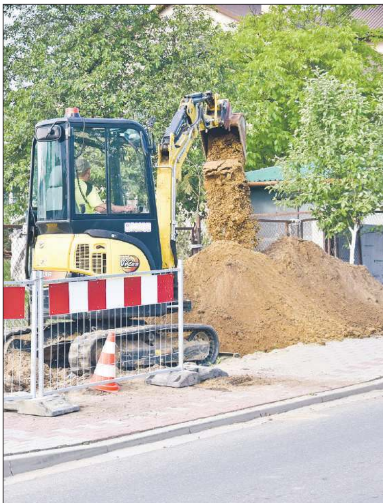
Na skrzyżowaniu w Pustyni ruszyły prace. Rondo jeszcze w tym roku.
