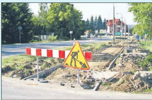
Remontowany jest chodnik przy ul. Sandomierskiej.
