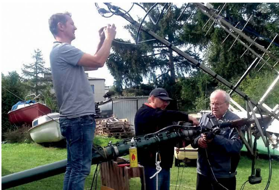
Podczas prac klubowych – montaż anten na 432 MHz
