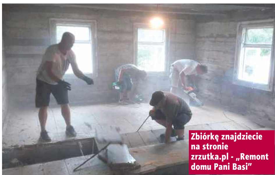
- Po dokładnym zapoznaniu się ze stanem podłogi, podjęliśmy trudną decyzję o jej demontażu - mówią druhowie z OSP Zabiele
