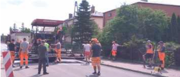
W czerwcu przyspieszono prace przy przebudowie części bialskiej ulicy Orzechowej. Pierwotnie inwestycja miała ruszyć jeszcze w 2023 r. W Białej Podlaskiej jednak realizowanych jest kilkadziesiąt różnych budów i remontów ulic
