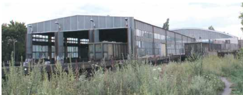
Dotąd został zachowany hangar użytkowany od kilkudziesięciu lat przez PKP jako parowozownia (widoczny w głębi obiekt z zaokrąglonym dachem). Po zajęciu przez Niemców w 1939 r. został oddany na potrzeby rozbudowującego się węzła kolejowego właśnie jako parowozownia
